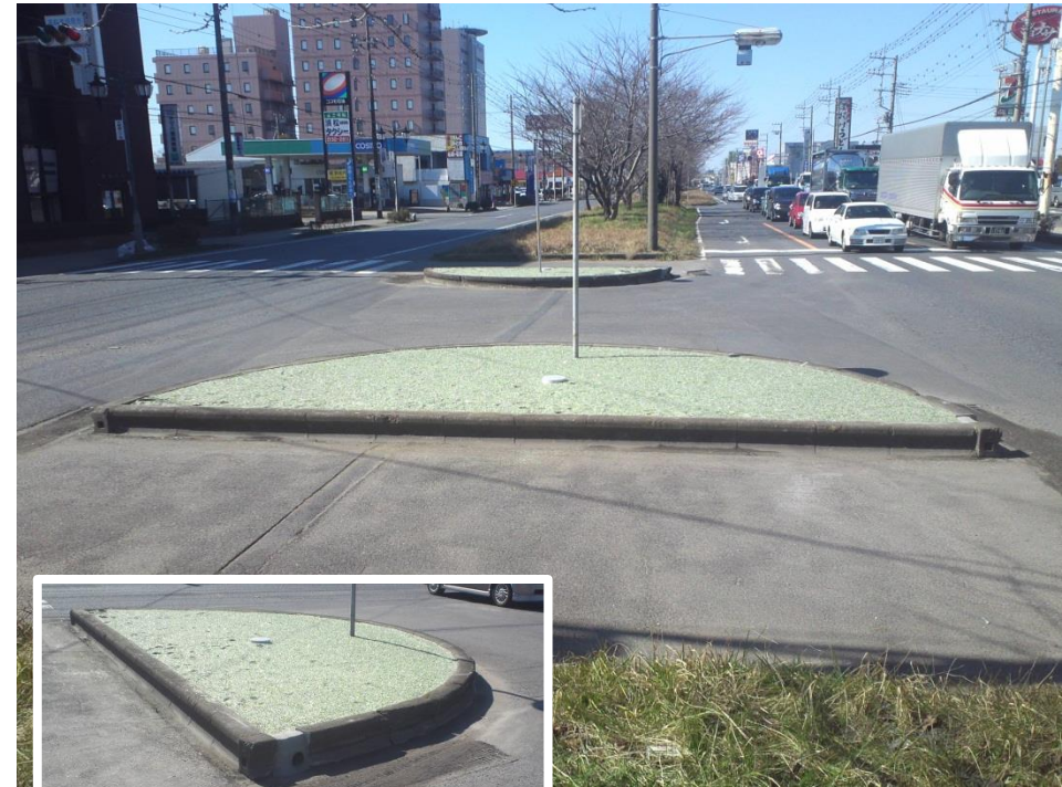
水たまりのできる箇所の水を中央分離帯内に流入させる。（厚さ50cm）
