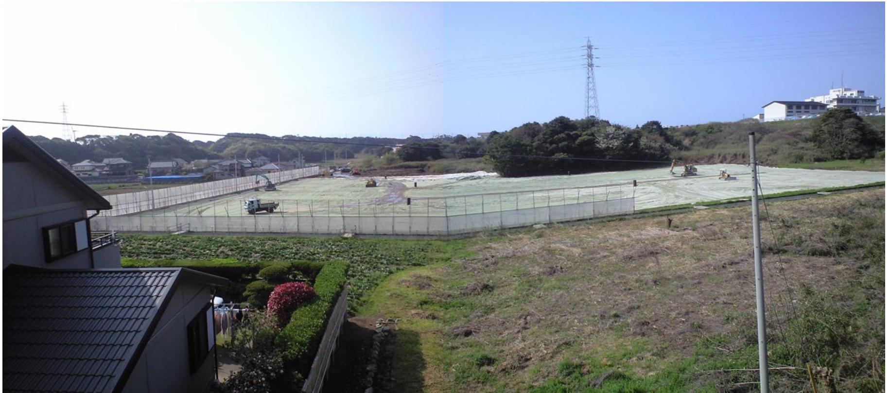
銚子市立銚子高等高校 第2グラウンド サンドマット兼雨水貯留浸透施設
