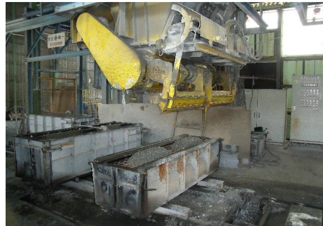
⑦コンクリートの打込み
