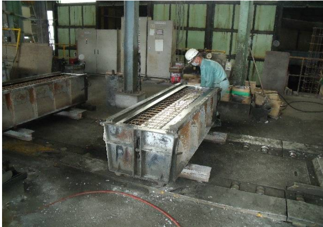
⑤組立鉄筋の挿入
