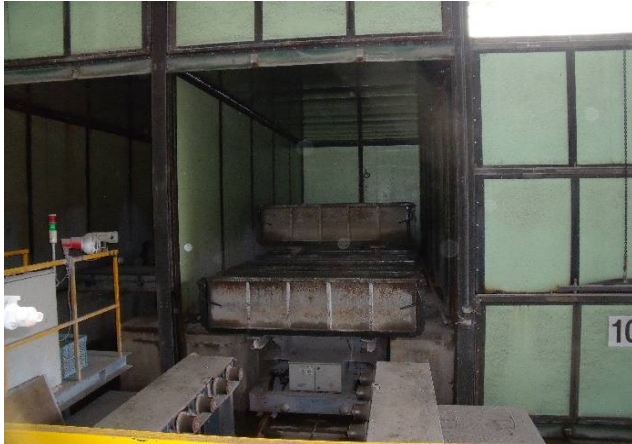
⑨蒸気養生
