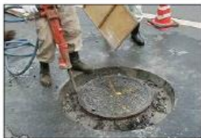
マンホール蓋の改築
