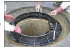
マンホール上部壁とマンホール蓋の締結による横ズレ防止
