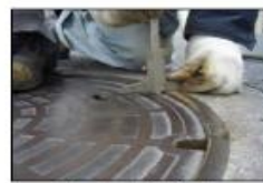
マンホール蓋及び公共汚水側蓋の点検・調査
