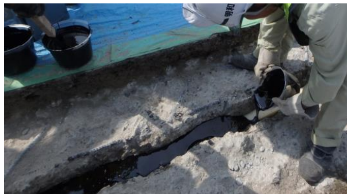
現場打ちタイ° (スカシールF2)
