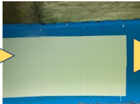
⑥シート貼り付け完了
