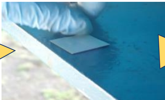
3. メタモルシート# 1 貼り付け
