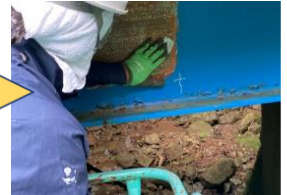
④シート貼り付け面を脱脂・清掃
